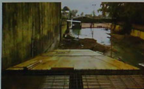
Preparación de la rampa.
