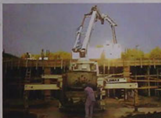
Llenado del encofrado.
