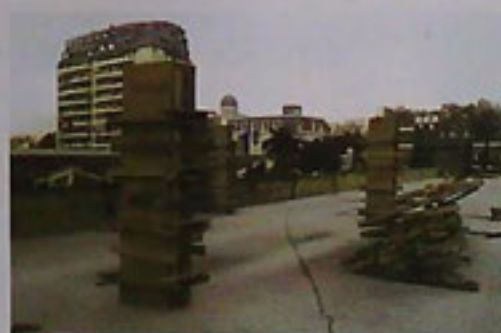
Comenzando la segunda etapa.
