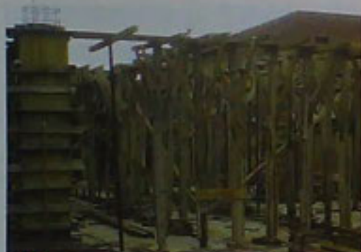
Armado del encofrado.
