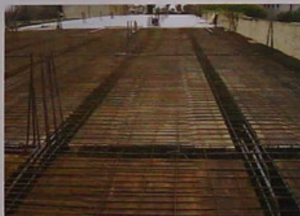
Llenado de la losa.
