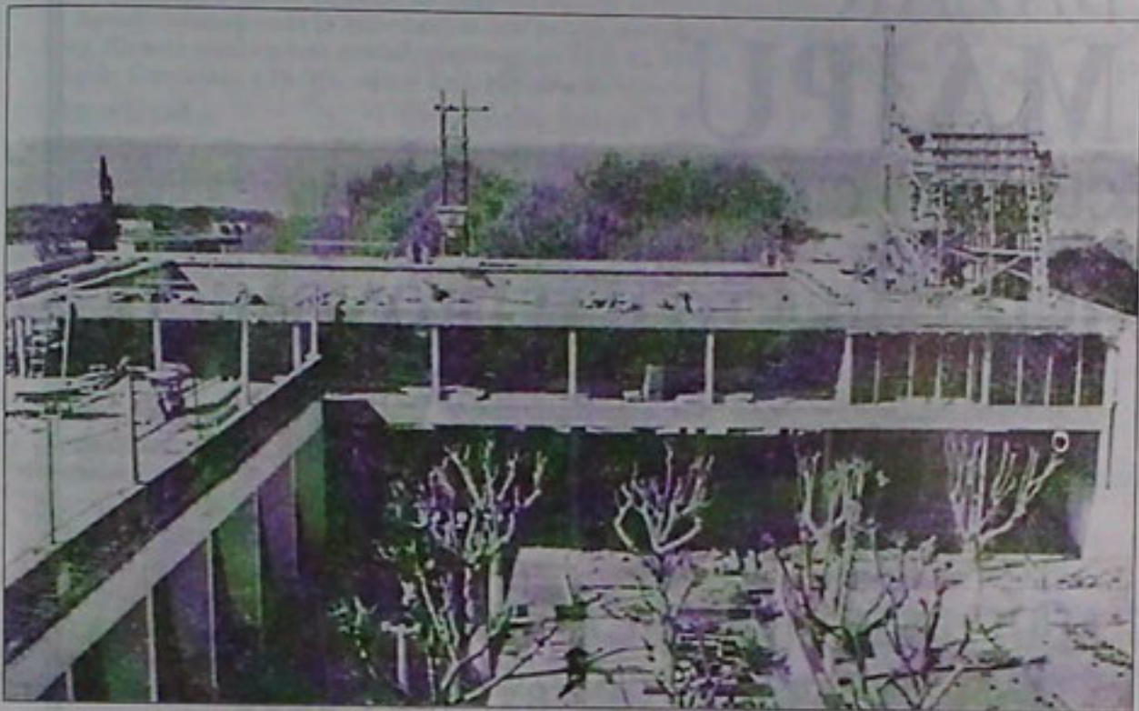
1965. Construcción de las piscinas en Vicente López
